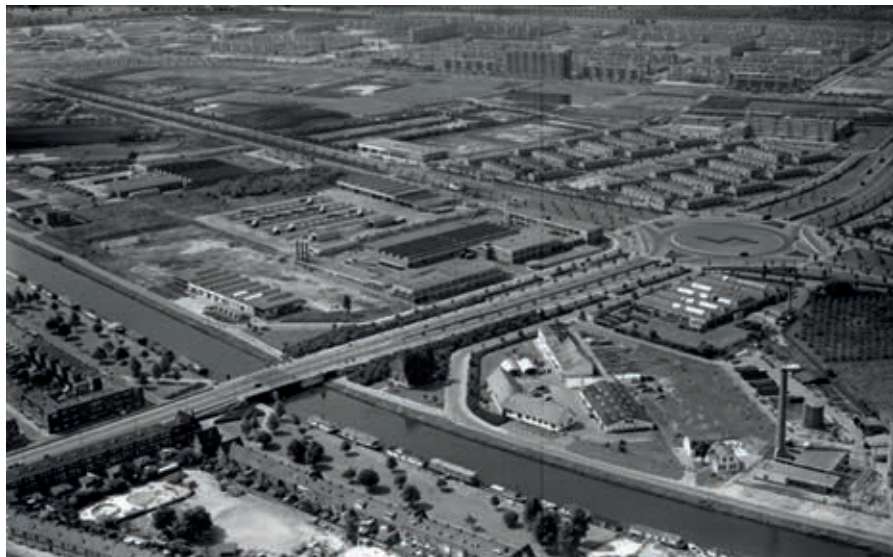
De Balijebrug net na de opening in 1959. Foto Wikimapia.
