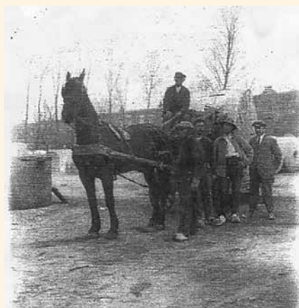
Vervoer van betonnen beerpotten
