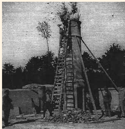
De watertoren in aanbouw
